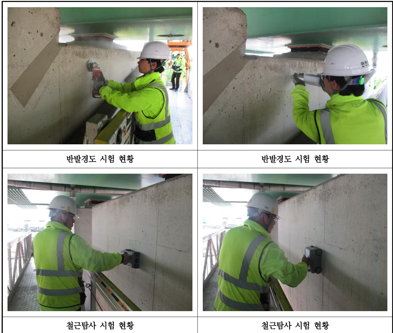
【사진 3.3.1】 콘크리트 내구성조사 현황
